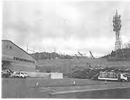
燃料チップ生産工場(左)と隣接する変電所(右)ちょうど背板の搬入も行われていた
